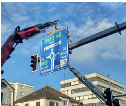
Montage von Grossflächentafeln
