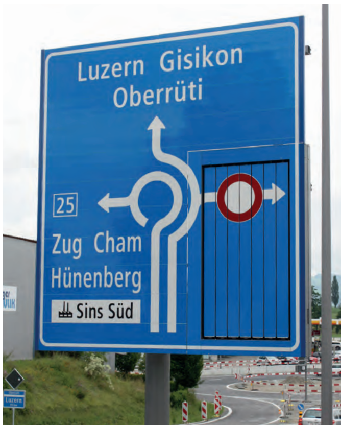
Profiltafel mit Prismen Teilwechselsignal
