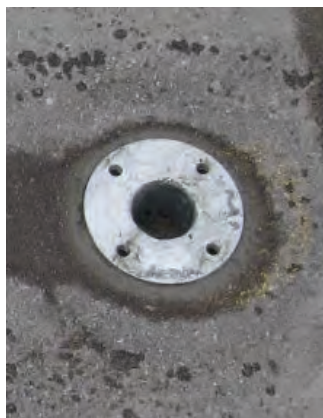
Einbetoniertes Bodenstück in Asphalt
