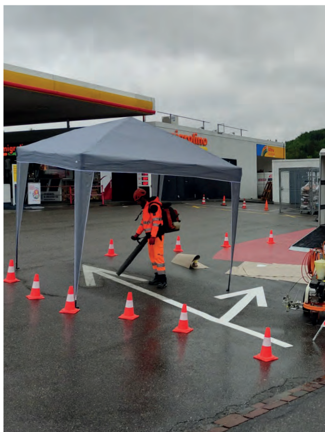
KSW Technik AG, Dättwil
