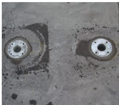
Einbetoniertes Bodenstück in Asphalt
