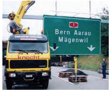
Mit einem LKW-Kran wird die Tafel hochgezogen und an die Signalbrücke montiert.
