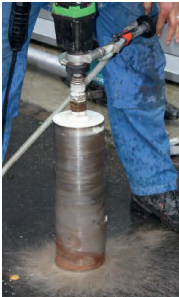
Kernbohrung in Asphalt
