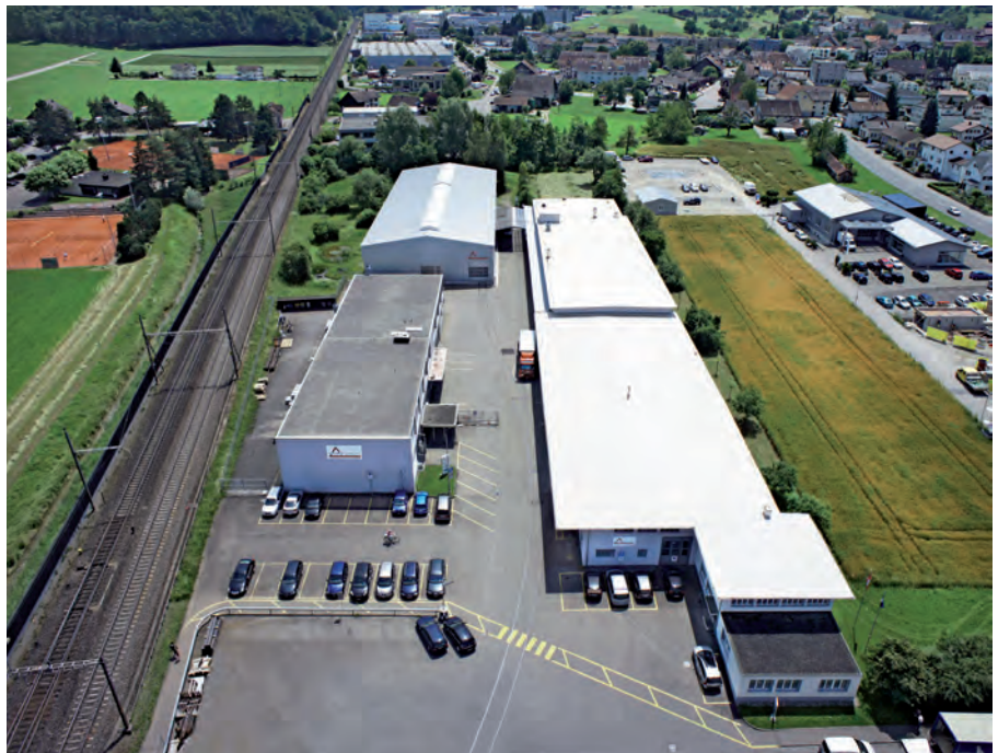
Renovationen beziehungsweise Isolationen der Gebäude in den Jahren 2007 bis 2013. Dadurch konnte der CO 2 -Ausstoss um rund 40% verringert werden.
