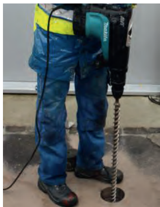
Lockern der verdichteten Kiesschicht
