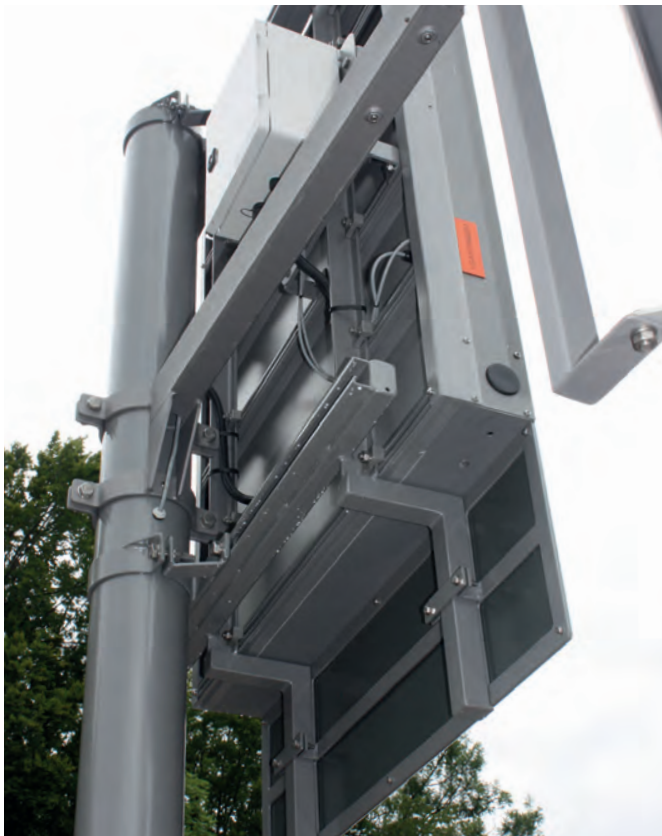
Rückseite und Konstruktion eines Wechselsignals
