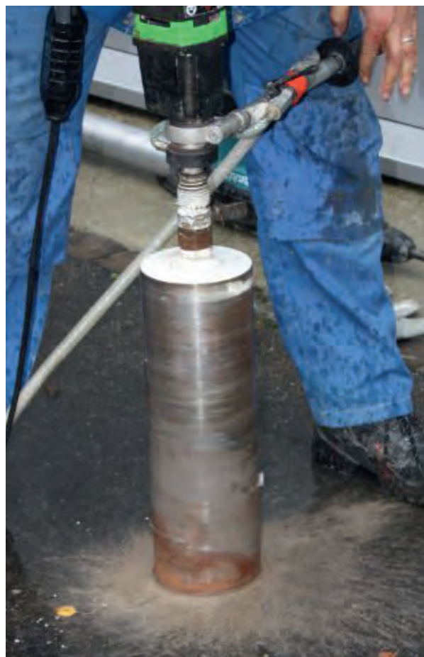
Kernbohrung in Asphalt
